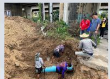
ประสานท่อประปาเชิงสะพานเดชาฯ มีผลเพิ่มแรงดัน โซน Bic C ถึงตลาดใต้ เพิ่มประสิทธิภาพ แรงดันการจ่ายน้ำประปาในพื้นที่ตั้งแต่แยก Big C ถึงบริเวณตลาดใต้(ฝั่งซ้าย)
