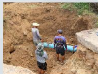
ประสานท่อประปาเชิงสะพานเดชาฯ มีผลเพิ่มแรงดัน โซน Bic C ถึงตลาดใต้ เพิ่มประสิทธิภาพ แรงดันการจ่ายน้ำประปาในพื้นที่ตั้งแต่แยก Big C ถึงบริเวณตลาดใต้(ฝั่งซ้าย)
