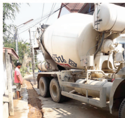
โครงการปรับปรุงท่อเมนประปา ซอยมาตุลี 35
