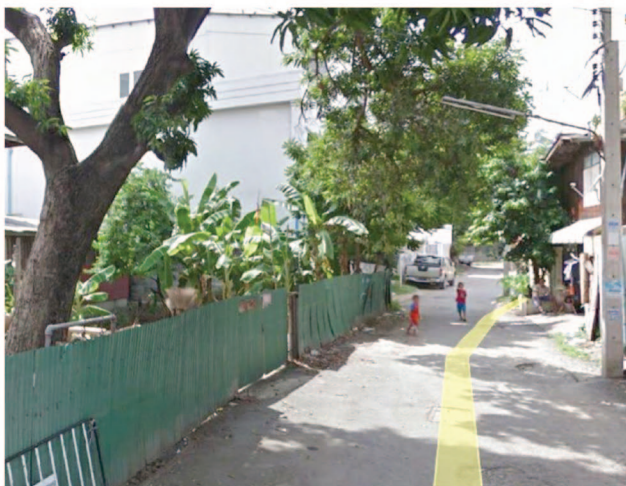
โครงการปรับปรุงท่อเมนประปา ชุมชนไชยศิริ
