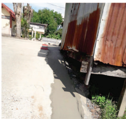
โครงการปรับปรุงท่อเมนประปา แควใหญ่ - โรงเรียนนิวาดี
