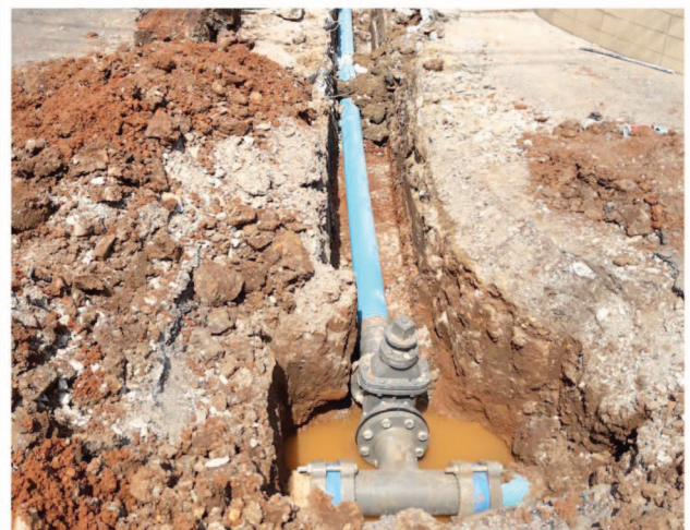
โครงการปรับปรุงท่อเมนประปา ซอยธรรมวิถี 7
