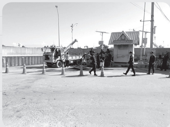
เจ้าหน้าที่เทศกิจอำนวยความสะดวกการจราจร เพื่อให้เจ้าหน้าที่สำนักการช่างบล็อกท่อระบายน้ำเพื่อป้องกันน้ำท่วม
